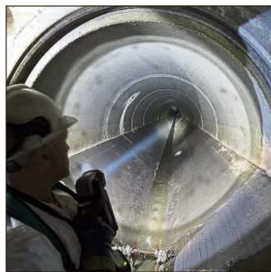
Blick in das Kanalnetz von Schweinfurt. FOTO DPA
