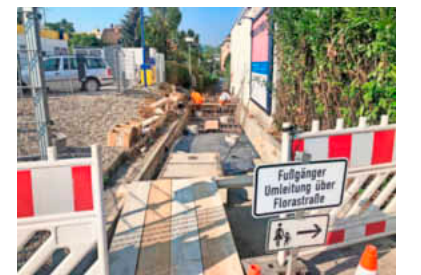
Nach Erdabsenkung: Betonplatte soll Gehweg stabilisieren. Foto: Rainer Reichert
